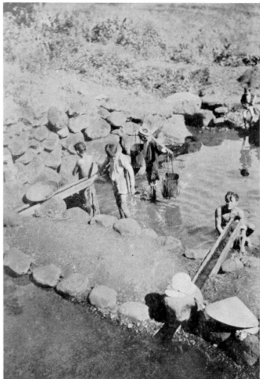
Planche XXIV. — Huyện de Gio -Linh. Village d'An -Hương — Installation Dưới — En avant, bassin supérieur ( N° 1 du plan ) ; deux becs de cuve En arrière, bassin d'alimentation ( N° 2 ).
