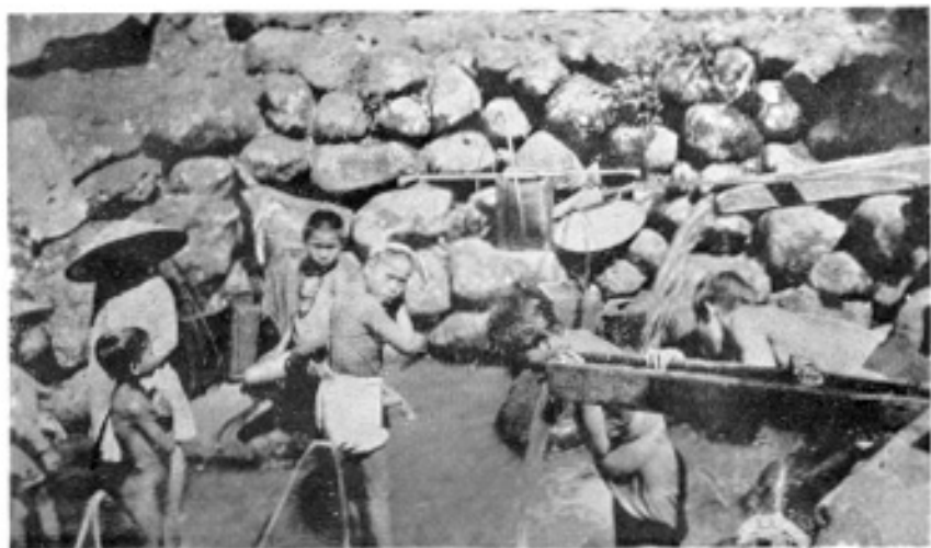
Planche XXVI. — Huyện de Gio -Linh. Village d'An -Hương— Installation Côi ( en haut ) — En avant, bassin d'alimentation ( N° 2 du plan ) ; becs de cuve en bois ( N° 3 ). En arrière, petit bassin supérieur ( N° 1 ). Au fond, mur ( N° 7 ). ( en bas ) — Bassin d'alimentation ( N° 2 du plan ) ; deux becs de cuve en bois ( N° 3 ). Indigènes.
