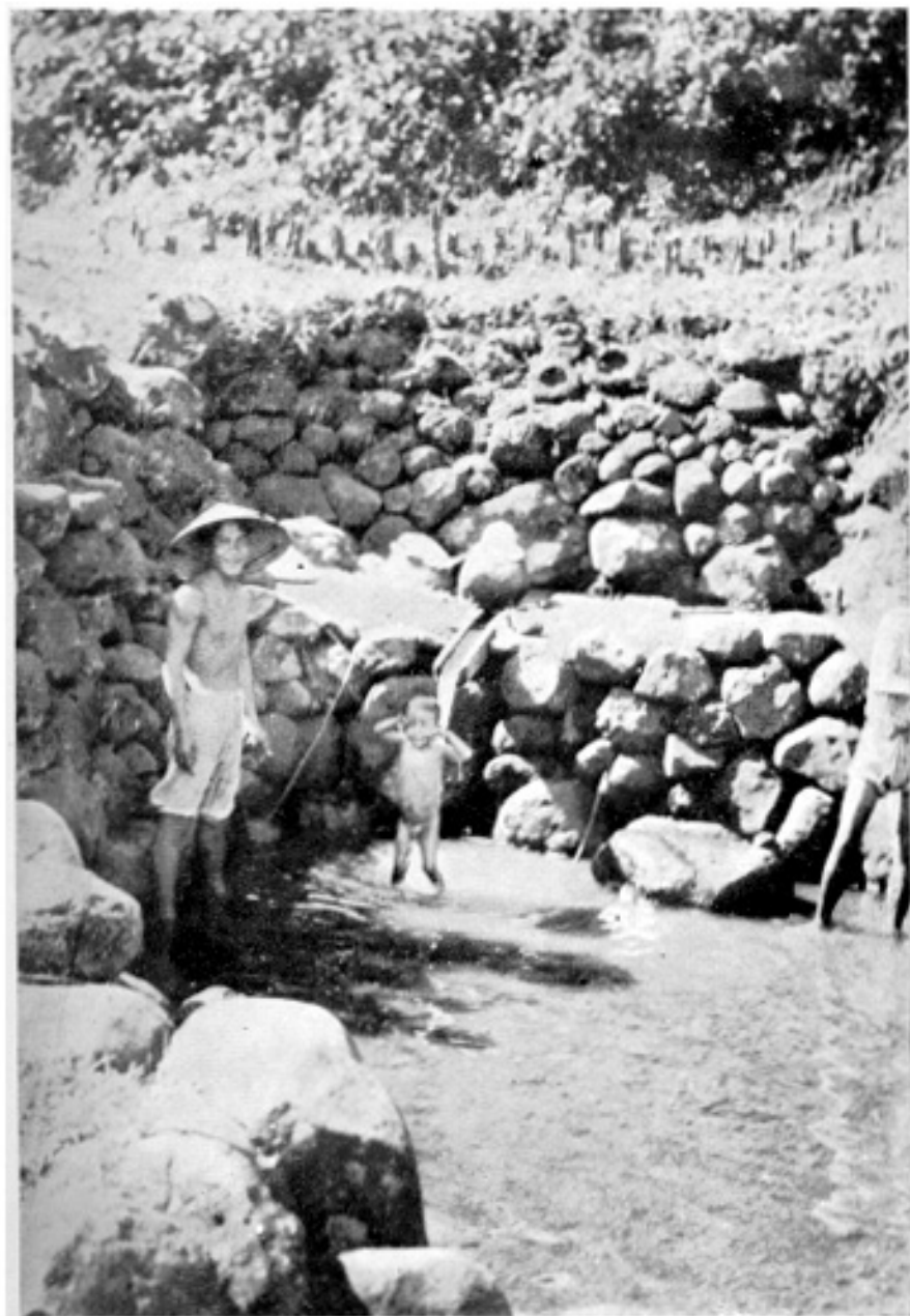
Planche XXV. — Huyện de Gio -Linh. Village d'An -Hương — Installation Côi — En avant, bassin d'alimentation ( N° 2 du plan ). Deux becs de cuve ( N° 3 ) ; sous l'un d'eux, un enfant, fils du Chef de Canton. En arrière, bassin supérieur ( N° 1 ).
