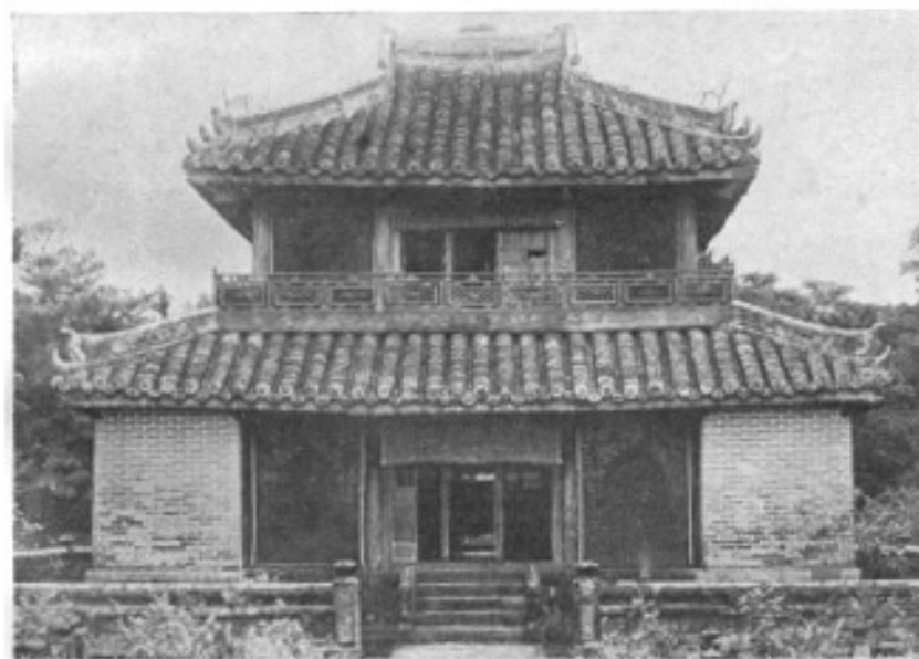
Planche II. — Au Tombeau de Thiệu-Trị — ( en haut ) la Porte de l'enceinte de la tombe ; — ( en bas ) le pavillon Đức-Hình ( Cliché G. G.).
