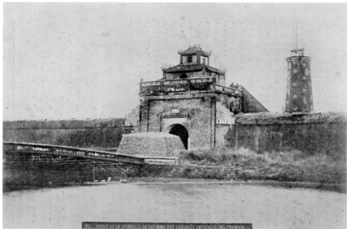
Planche LXXVI [ Photo XV ]. — La porte principale de la citadelle de Bắc -Ninh, en mars 1884.
