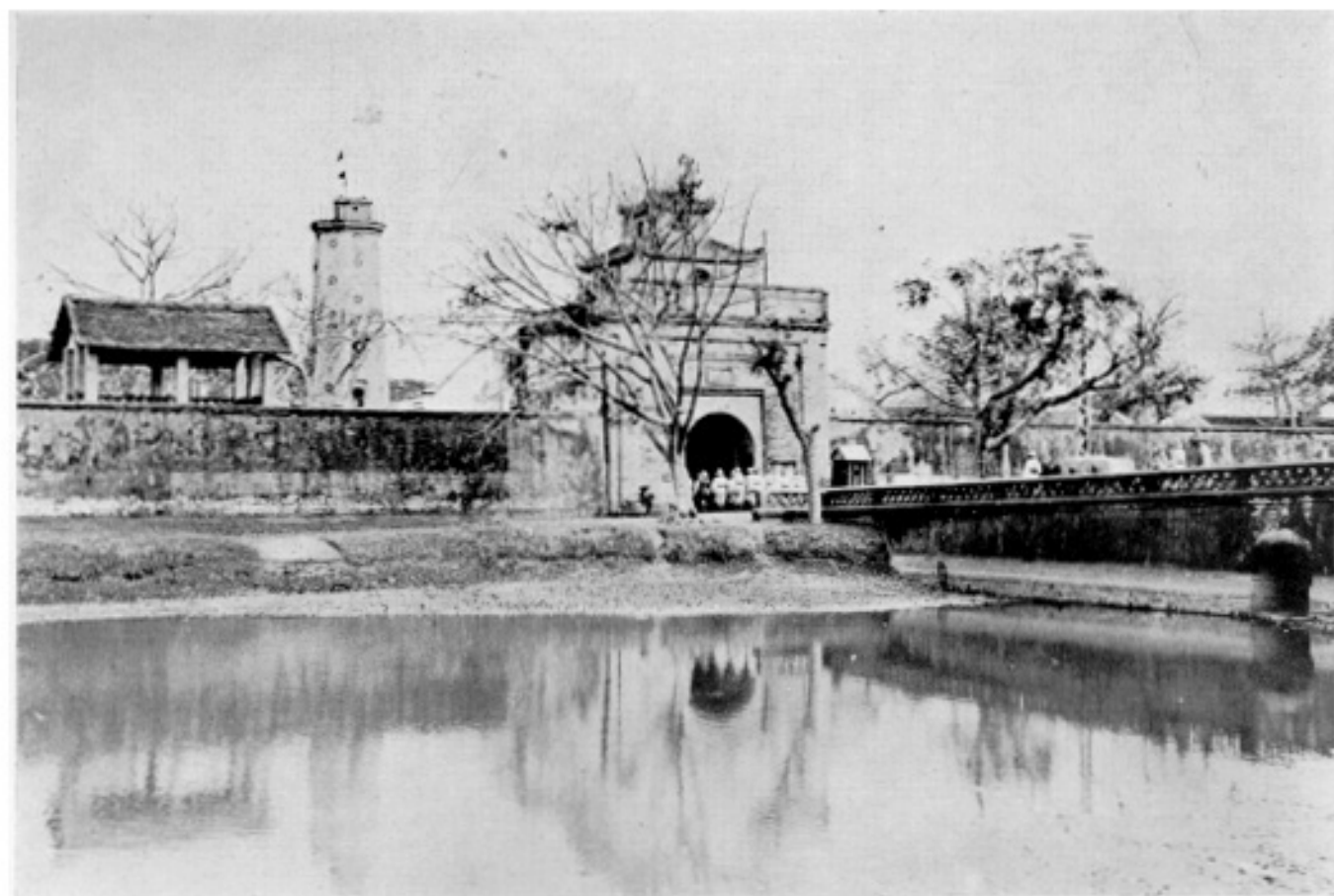
Planche LXVI [ Photo V ]. — La porte principale de la citadelle de Bắc -Ninh et la Mirador, vus de l'extérieur, en l'état actuel.
