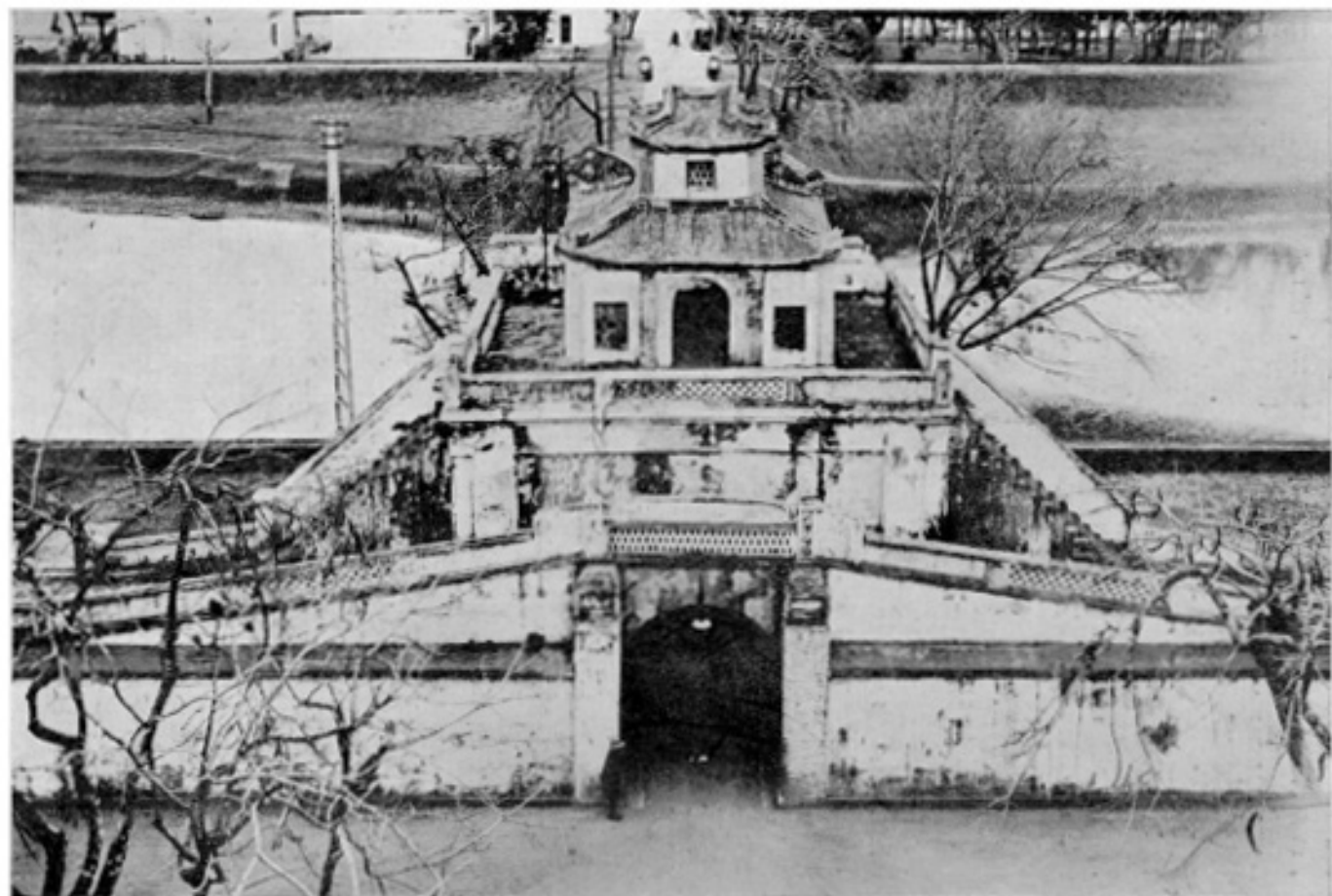
Planche LXVII [ Photo VI ]. — La porte principale de la citadelle de Bắc -Ninh, vue du sommet du Mirador, état actuel. ( Cliché de l'Ecole Française d'Extrême -Orient ).
