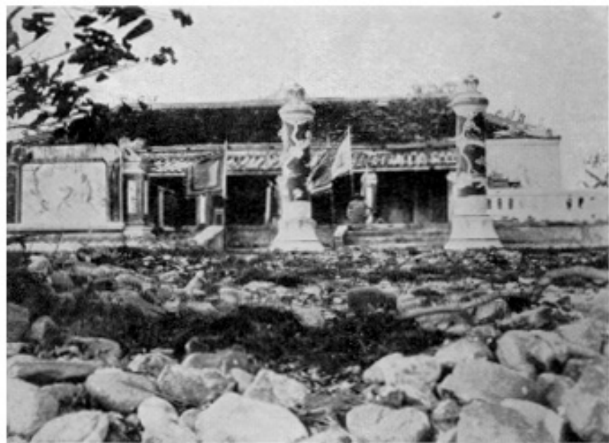
Pl. CLX. — Miếu - Công - Thần — Temple dédié aux soldats de Gia - Long.
