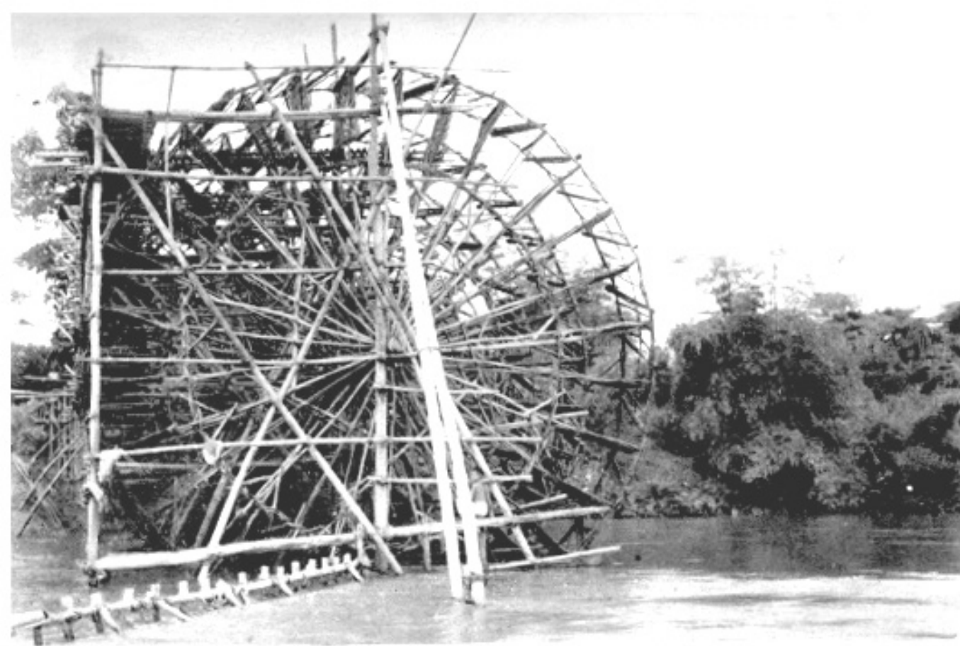
Planche LXVII ( Photo 41 ). — Montage de la noria : la noria est terminée ; les palettes et les godets sont en place ; les tréssillons de serrage sont nettement visibles ; remarquer le portement de l'essieu ; à gauche, au premier plan , le barrage, encore peu étanché ; à droite, au point où les palettes émergent, ensemble du coursier.
