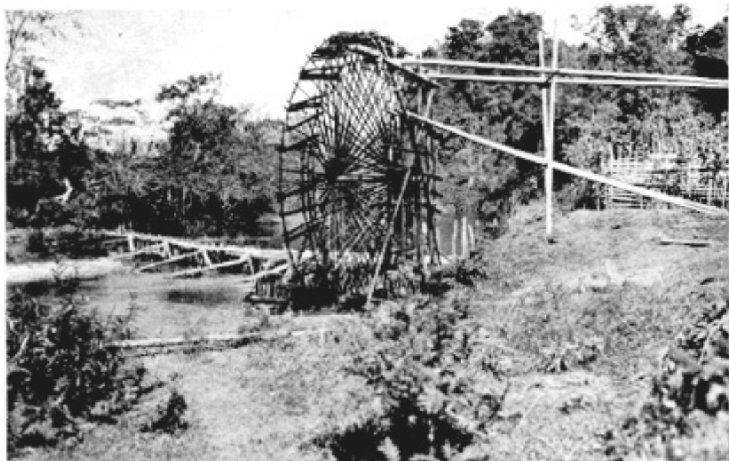
Planche XLVII ( Photo 21 ). — Noria de Bai - Thong : les gouttières, le barrage.
