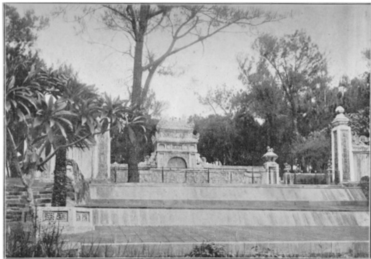
Planche V. — Le tombeau du Prince Kiên -Thái -Vương : terrasse, écran extérieur et porte d'entrée.
