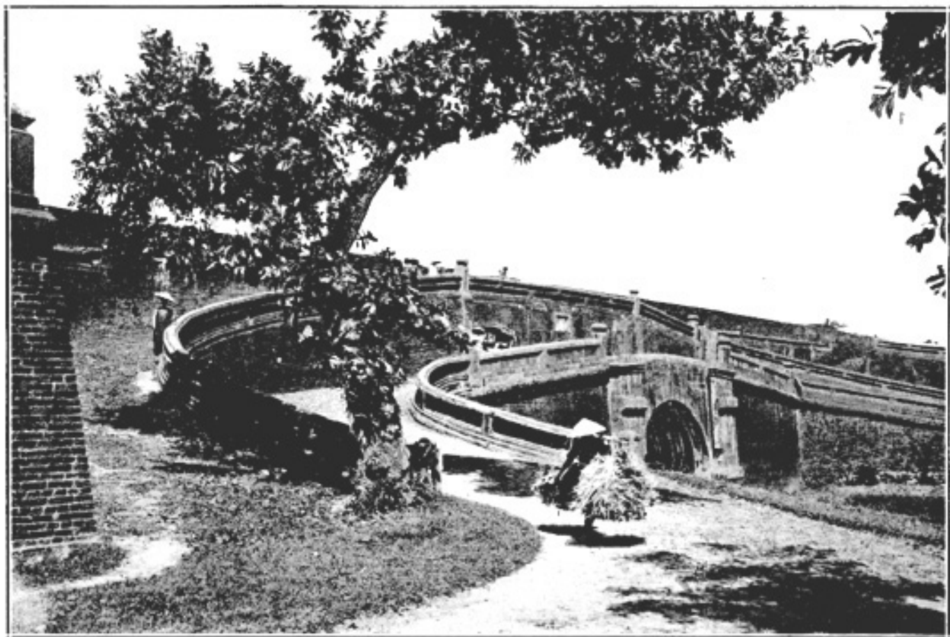
Planche LXXVIII. — Le pont Tây -Thành -Thủy -Quan, et ses deux rampes incurvées.
