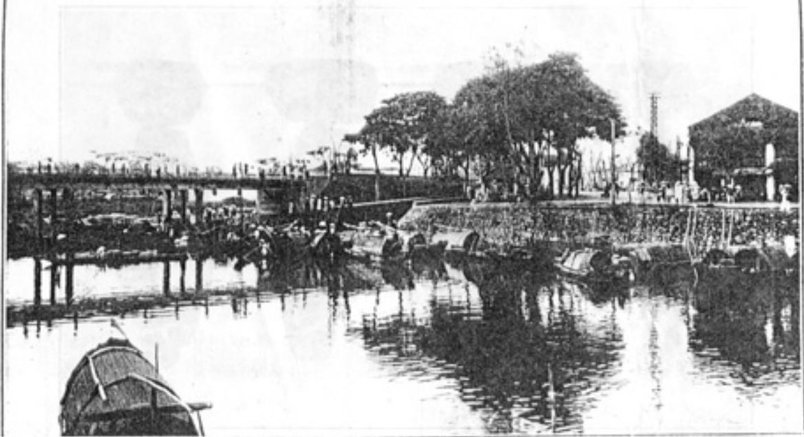
Planche XIV. — Le Pont de Gia -Hội, état actuel. (Photographie communiquée par M. H. Cosserrat.)
