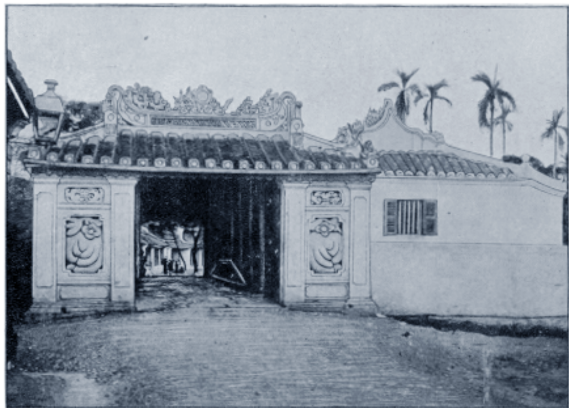
Planche XXVIII. — Le pont japonais, à Faifo : entrée, du côté Est.
