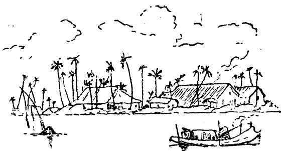
Fig. 163. — Le cercle des officiers à Thuận-An .
