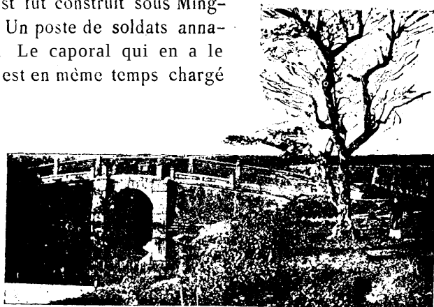
Porte des eaux de l'Ouest, au Canal impérial. (Cliché KHOÁ).
