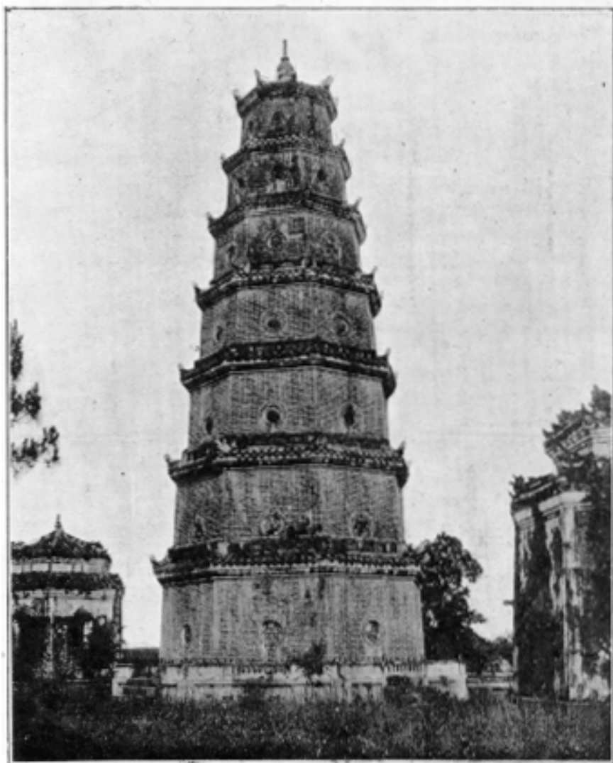
Planche XXX. — La tour de la Source du Bonheur, à Thiên -Mẫu, vue par derrière. (Cliché Pierron.)
