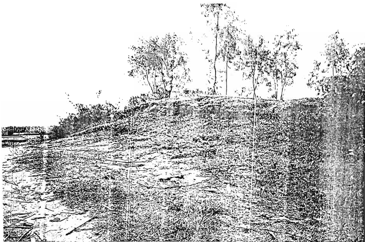
Đoạn lũy thành hướng Tây Bắc bị san gạt làm đường giao thông
